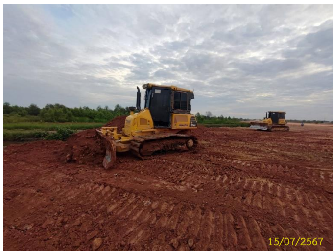
รูปที่ 13 การบดอัดดินให้เรียบร่อนก่อนเปิดพื้นที่ส่วนอื่น
