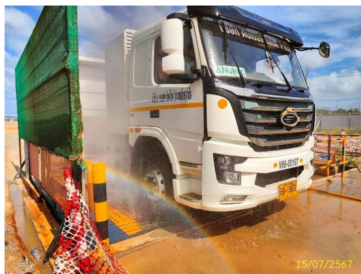
รูปที่ 7 ป่อล้างล้อรถบรรทุกก่อนออกจากพื้นที่โครงการ
